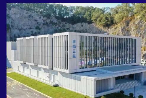
液冷数据中心
