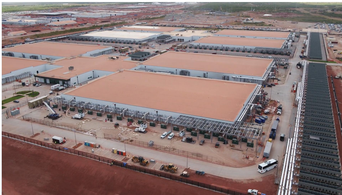
星际之门(带自然冷的风冷冷水机组)
